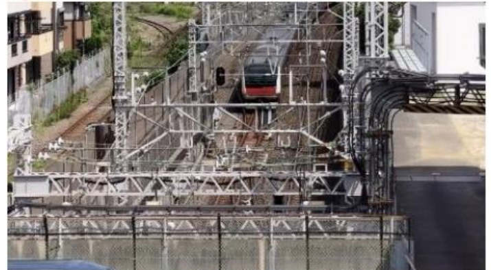
京葉線の防水扉、架線を切りながら閉扉とのこと
